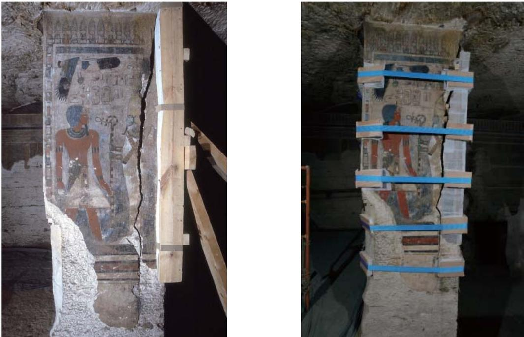
図24 J室第3柱南面ラッシング・ベルト取付け前および取付け後
